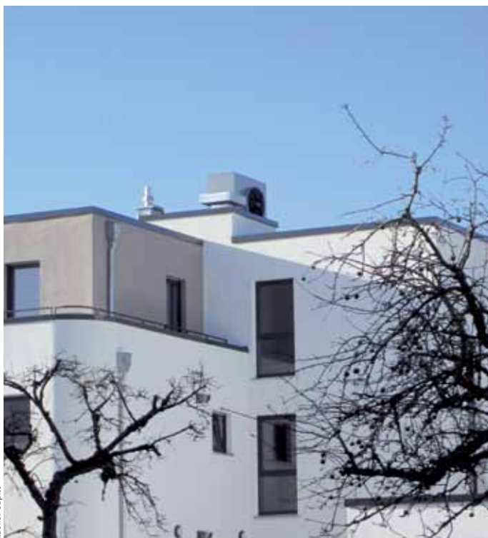
Montierte Wärmepumpe auf dem Dach des Haupthauses
