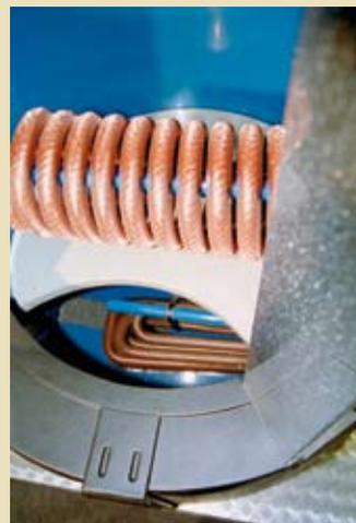
der Kunststoffplatte ausgeschnitten, um die Funktionsweise zu verdeutlichen. Für die Wärmeübertragung zwischen der Aufheizzone (unten) und der Trinkwasser-/Heizungserwärmungszone (oben) sorgt eine simple Konstruktion mit je einem Fall- bzw. Steigrohr. Über diese Strömungskanäle baut sich die Schichtung nach dem Prinzip der Schwerkraft auf: Abgekühltes Wasser sinkt nach unten in die Aufheiz-Pufferzone und verdrängt dadurch erwärmtes Heizwasser in den
